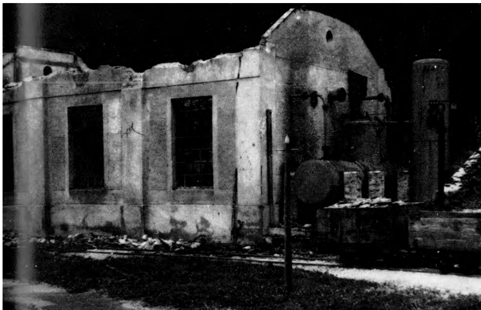
Uničena strojnica rudnika Huda jama pri Laškem po napadu 1. štajerskega bataljona 2. 6. 1942
