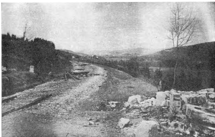
Uničena železniška proga med Grosupljem in Zdensko vasjo
