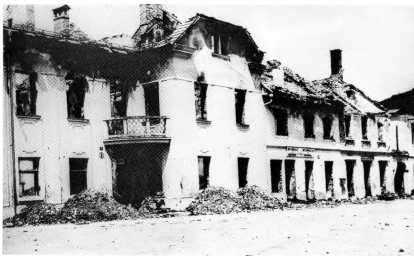
Prizor iz požgane Cerknice ob sedanji Cesti 4. maja. Od leve Je najprej del nekdanje Žumrove gostilne, nato Kranjčeva in Verletova trgovina ter delno Gojupova pekarna
