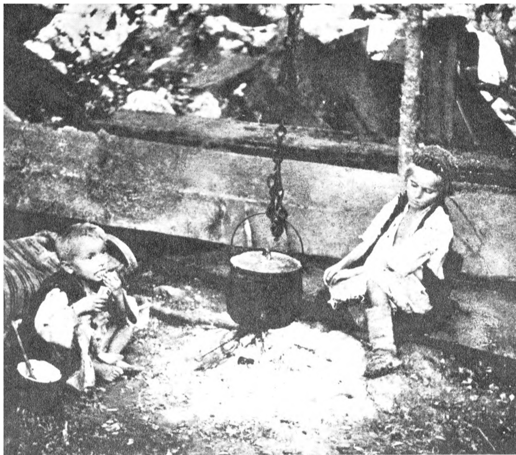
GLAD U JANJU KOD JAJCA, OKTOBRA 1942. ZAKLON U SUMI NAPRAVLJEN JE OD DASAKA RAZRUŠENE KUĆE
