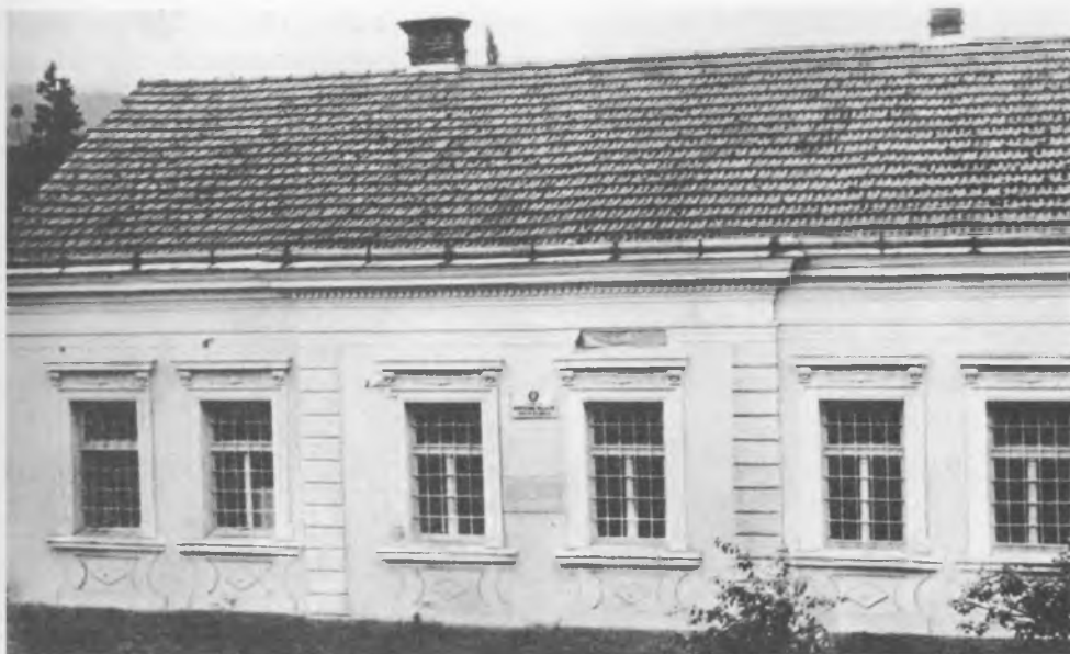
Zgrada oružničke postaje u Donjoj Stubici na koju je izvršen partizanski napad 9. 4. 1942.
