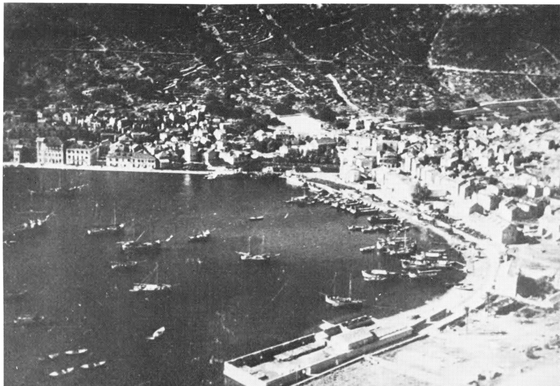
SI. 86 - Zapadni dio luke u Visu. U prvom planu Centralna mehanička radionica i sidrište brodova, Vis 12. septembra 1944.
