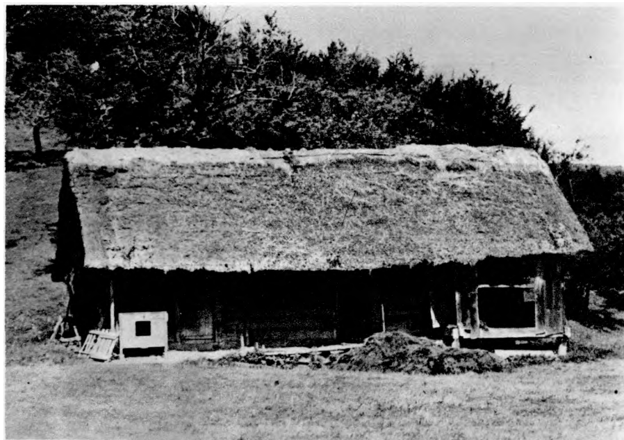
Gospodarske zgrade Pepeka Masnjaka, jedno od boravišta boraca ZPOH zime 1941. 1942.
