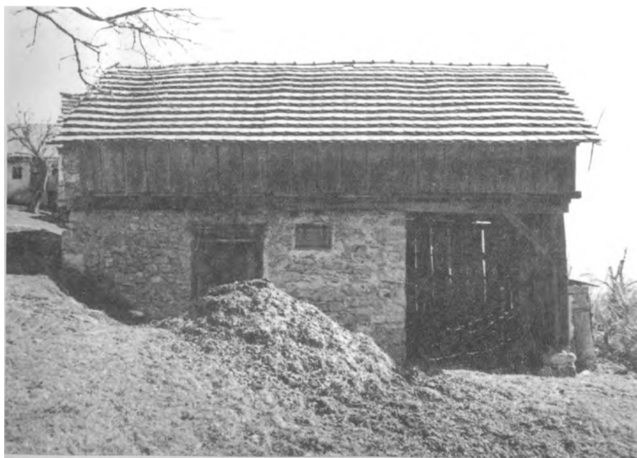
SI. 21 - Tihočaj 5. Štala Janka Gvozdanovića sa senjikom koji je položen na stupove, stupe i s tri strane zatvoren daskama.
