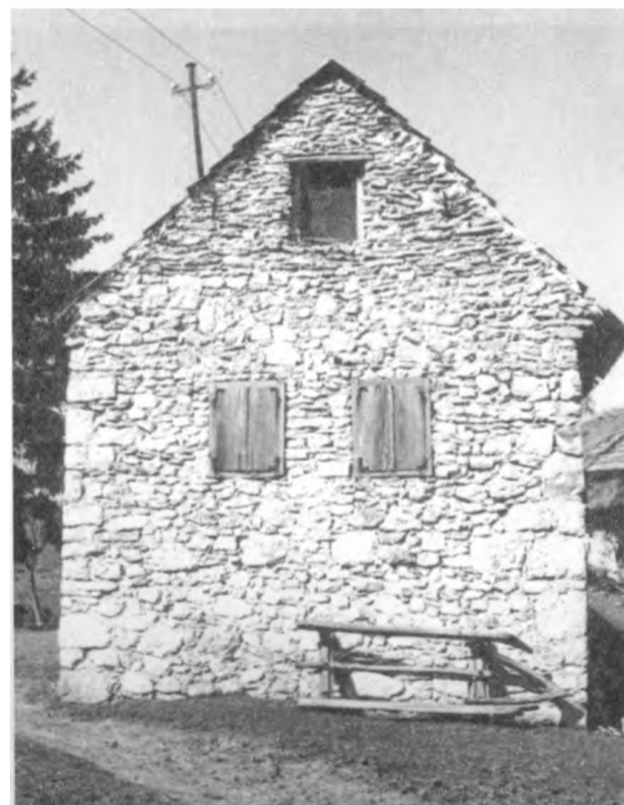
SI. 11 - Tihočaj 11, kuća Nikole Fratrića izgrađena 1944. godine.
