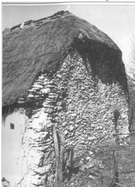
SI. 12 - Pavkovići 6, stražnji zabatni dio napuštene i ruševne kuće katnice Petra Pavkovića; cijeli zabat zidan je u kamenu.
