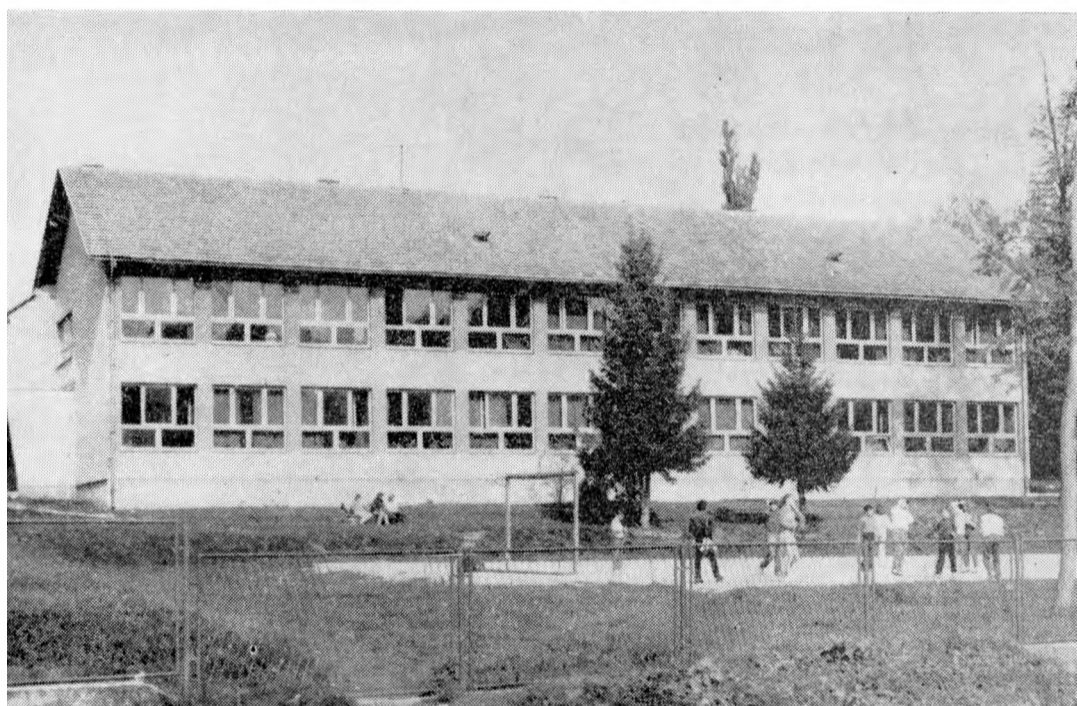
Vojnić, tvornica drvene galanterije u izgradnji.
