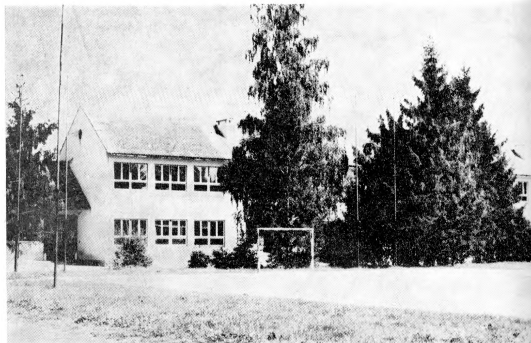
Zgrada Osnovne škole »Žarko Cuić« u Vojniću.
