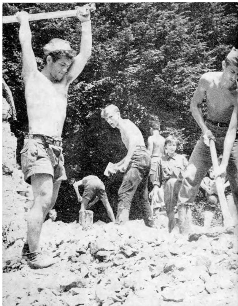
Pripadnici JNA i omladina na izgradnji ceste kroz Petrovu goru u pravcu Muljava—Petrovac 1961.
