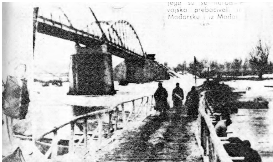
Pontonski most podignut na Dravi nedaleko od porušenog železničkog mosta. Preko tog pontona vojska i narod su se u martu 1945. za vreme velike neprijateljeve ofanzive, prebacivali u Mađarsku, na oslobođenu teritoriju
