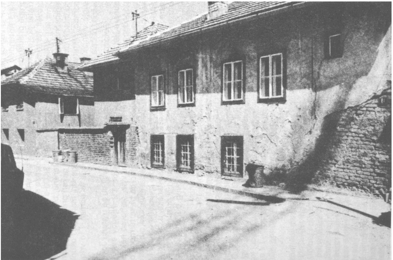
Kuća u Karpuzovom sokaku (danas ul. Hriste Botava 19) - ilegalno spremište oružja i municije
