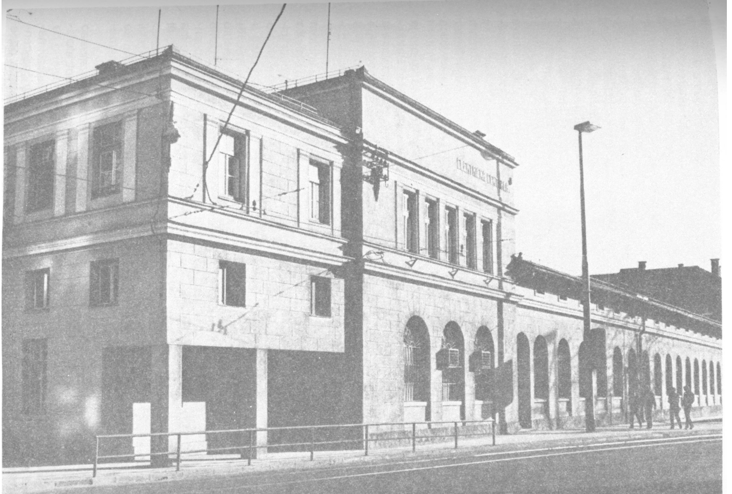
Zgrada Elektrine centrale, jedan od značajnih objekata Sarajeva, koji su udarne grupe uspjele sačuvati od razaranja
