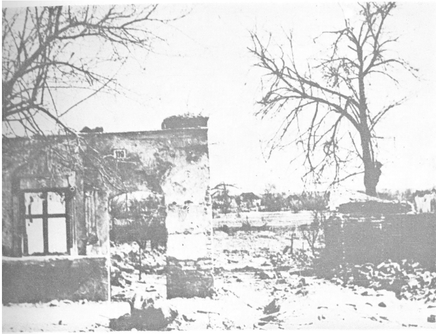
Deo porušene železničke stanice u Batini
