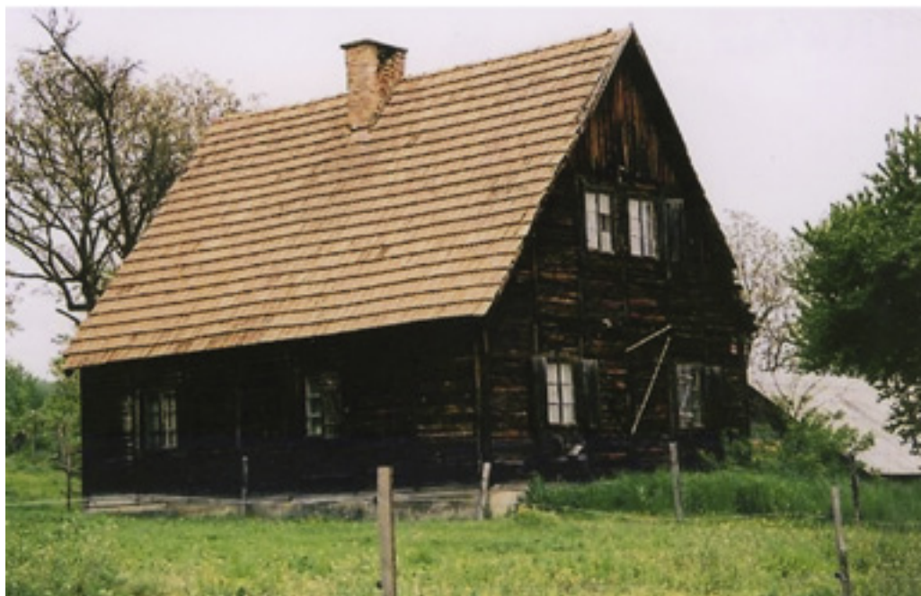
59. Blokhaus v Globokem. Nemške oblasti so v Posavju za kočevske Nemce zgradile veliko hiš – t. i. Blokhausov, ki so bile narejene po enotnem načrtu.
