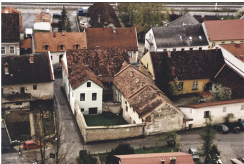
18. Sodišče in sodni zapori z ograjenim dvoriščem v Sevnici.
