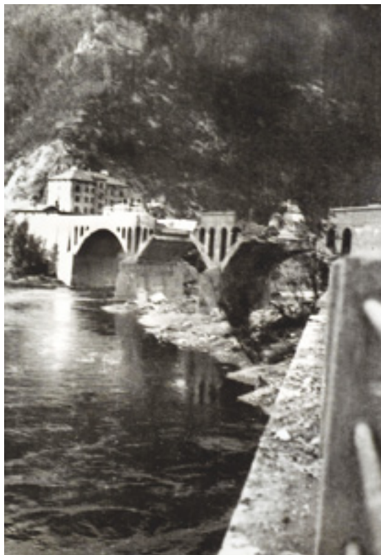
86. Železniški most v Zidanem Mostu so zavezniška letala leta 1944 in 1945 večkrat bombardirala. Južni most je bil močno poškodovan že v napadih 17. in 18. novembra.
