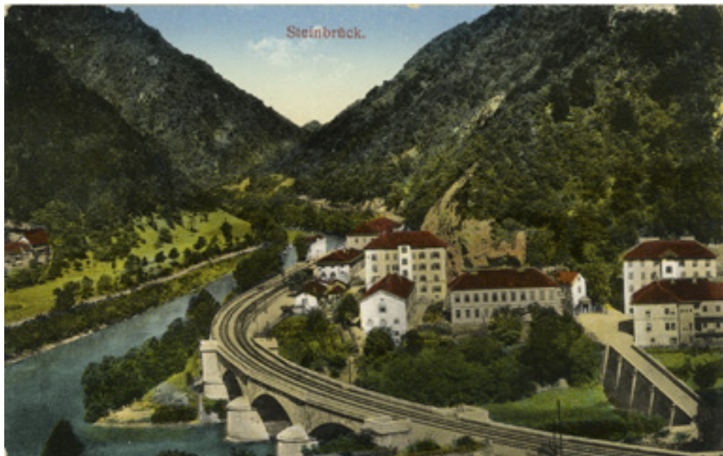
74. Zidani Most je mednarodno železniško križišče. Razglednica. Iz leta 1917.
