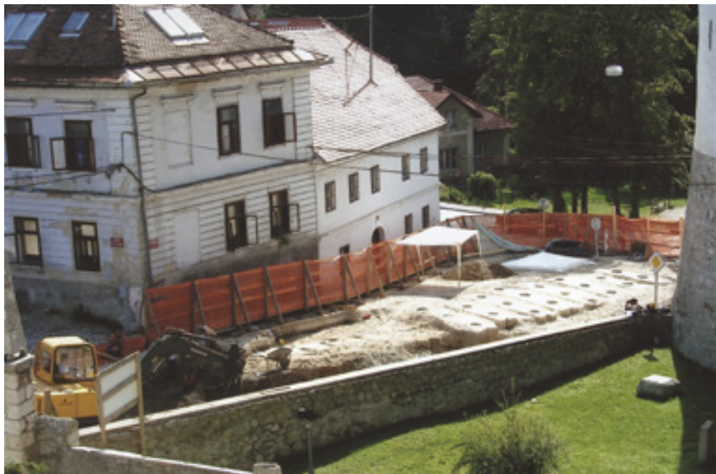
150. Ostanki nemških betonskih protipehotnih ovir pri gradu Brežice.
