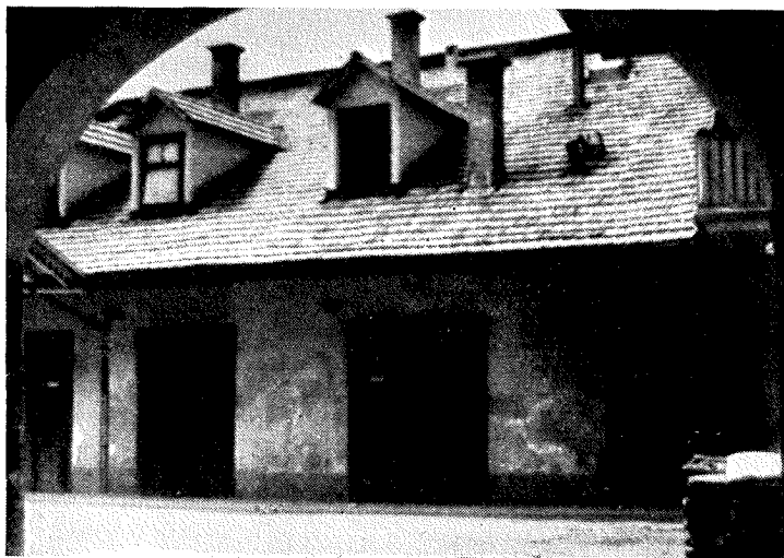
Na podstrešju v tej dvorišni zgradbi na Emonski cesti v Ljubljani je bila ilegalna tiskarna »Tunel«
