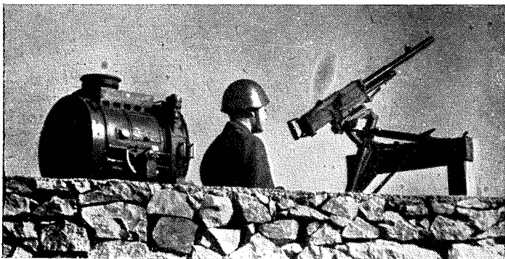
Z električnimi žarometi in strojničnimi gnezdi je bilo taborišče internancev na otoku Rabu »zavarovano« pred vsakim presenečenjem...
