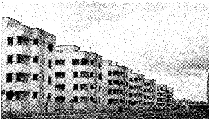
Jeseni leta 1956 so angleški in francoski bombniki bombardirali Port Said. Na ruševinah pa so že zrasle nove zgradbe. Na sliki: del novega stanovanjskega naselja, ki so ga zgradili v rekordnem času — v 100 dneh so zrasla nova stanovanja za 40.000 ljudi
