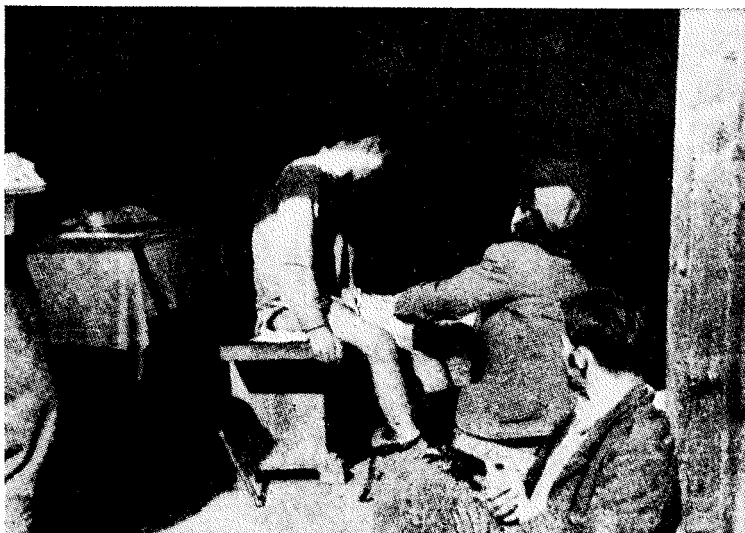
Zasilna dolinska bolnišnica v vasi Novi Tabor pri Črmošnjicah. Foto dr. J. Milčinski, september 1944
