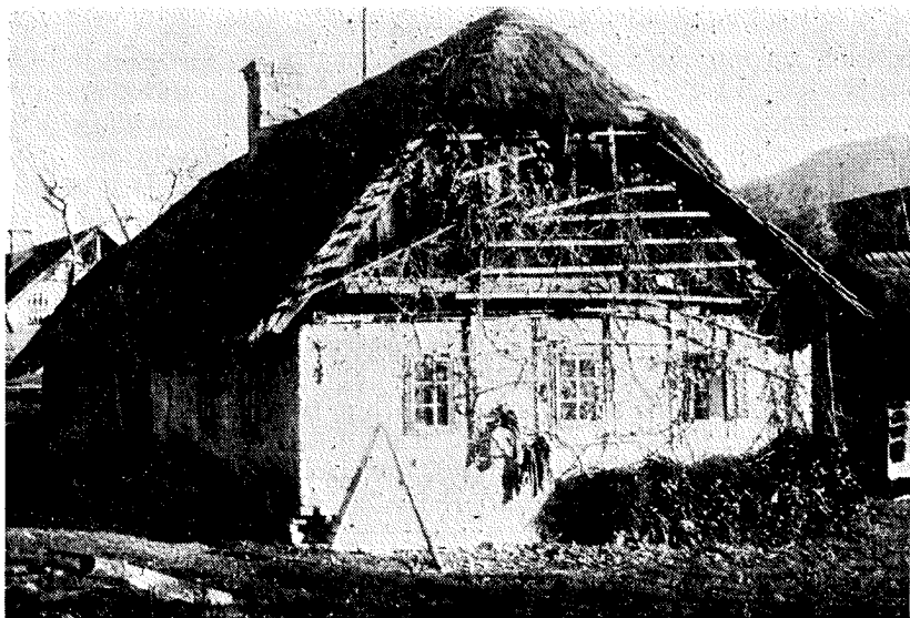
Javka pri Štrukeljcu v Zaglinku
