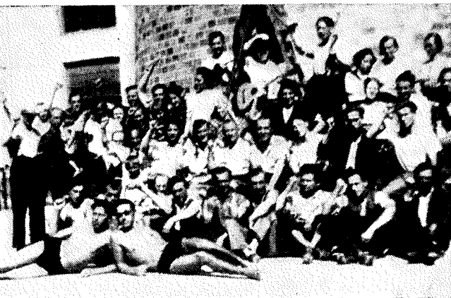
Skupina stavkajočih delavcev v obratu tovarne Toma na Pobrežju
