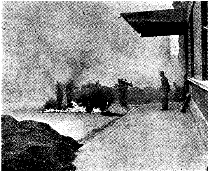
»Gašenje« požara v industrijskem objektu
