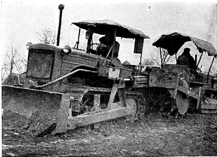
Z avtoceste Ljubljana—Zagreb: zemeljska dela pri nasipu v Šmarju
