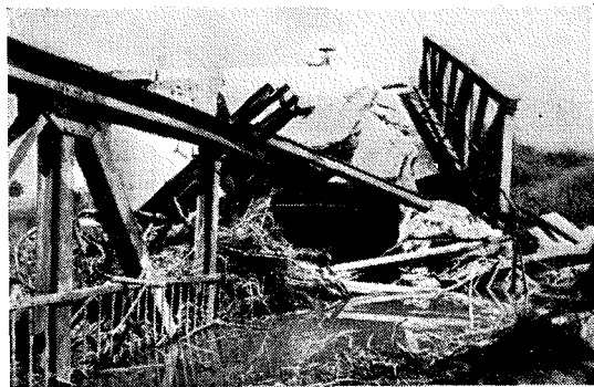
Porušeni most v Metliki
