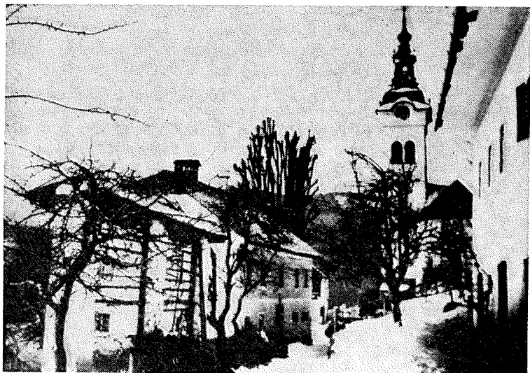
Stara dražgoška cerkev s šolo, župniščem in prosvetnim domom
