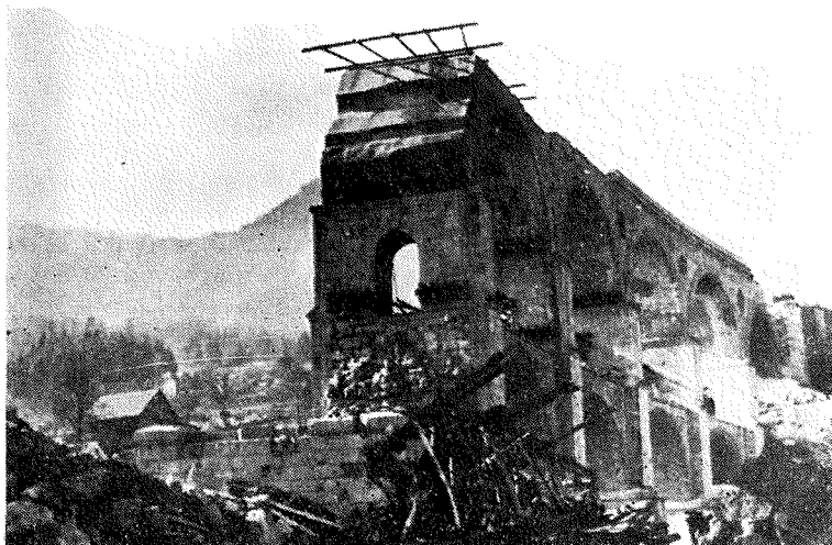
Porušen borovniški most
