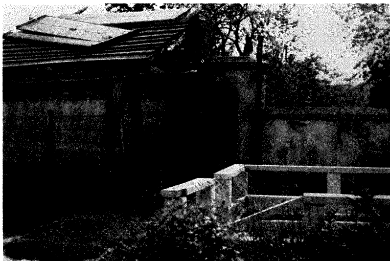
Bunker ob pokopališkem zidu
