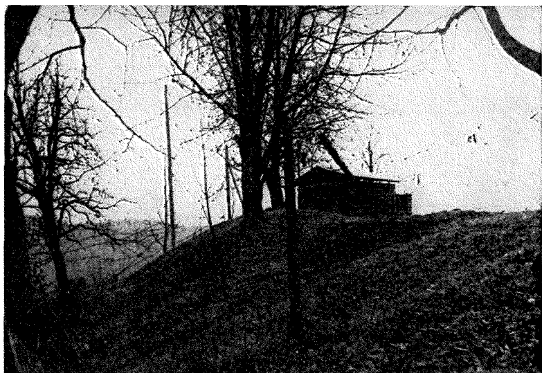
Bunker in električni drogovi v zunanjem obrambnem obroču na Sv. Urhu
