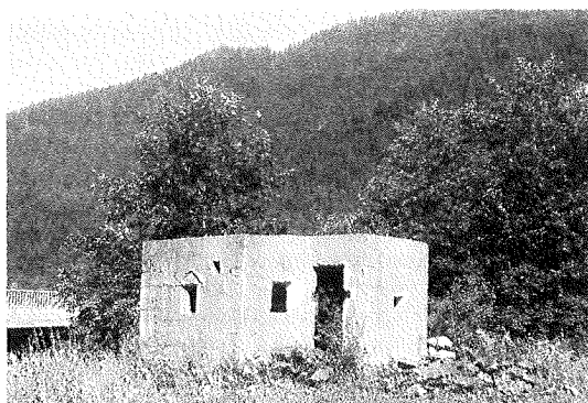
Bunker za varovanje cestnega mostu na Praprotnem
