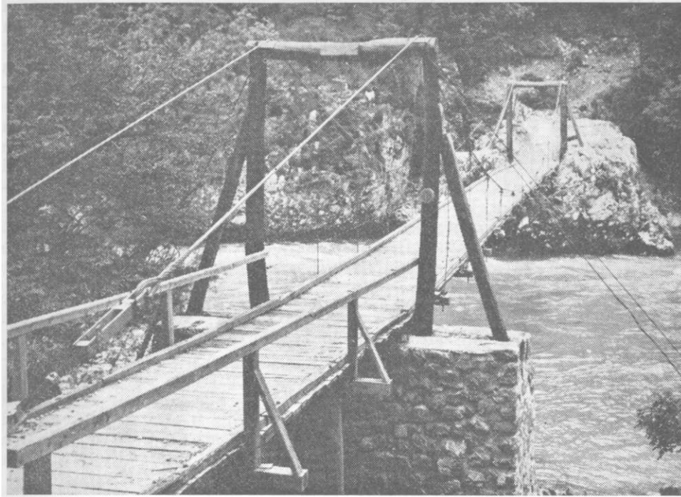
Most na Pivi u Donjem Kruševu (obnovljen)
