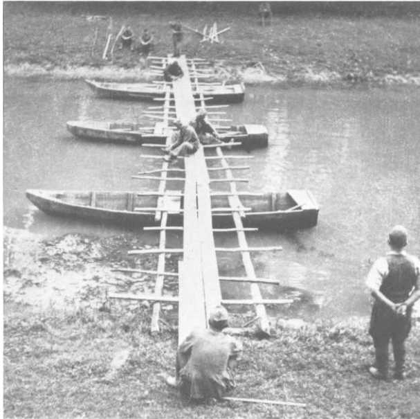
Lijevo: Izgradnja prijelaza. Pontonirska četa Trideset treće divizije, ljeta 1944.
