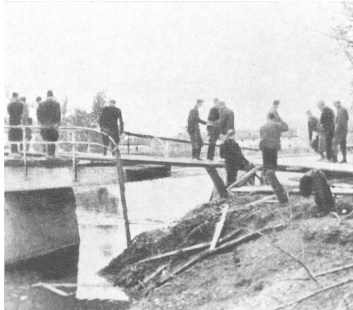
Инжињерци 1. пролетерске бригаде оспособљавају мост на реци Вуки, у Вуковару, 12. априла 1945 (из књиге „Прва пролетерска од Београда до Загреба“)
