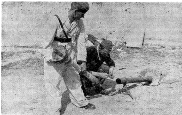
Partop (partizanski top) sa dometom do 200 m. Po efikasnosti bio je ravan haubici, ali nedovoljno precizan i nepouzdan
