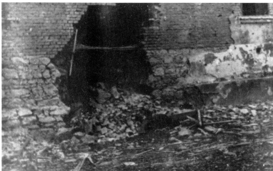
20. septembar 1944. godine - grad Arandelovac je oslobođen osim velike zgrade »Staro зда- nje« iz koje se krvnički branilo oko 250 četnika i nedičevaca. Borci brigade minirali su zgra- du, a od eksplozije je napravljena rupa na zidu kroz koju su borci postepeno ulazili i kroz borbu primorali neprijatelja na predaju. Snimak prikazuje izgled zgrade poslije izvršenog mi- niranja.
