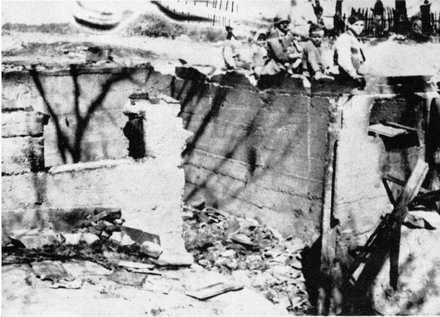
Zgarište kuće A. Škaljca, Sjeniĉak (Foto: B. Nikoliš)
