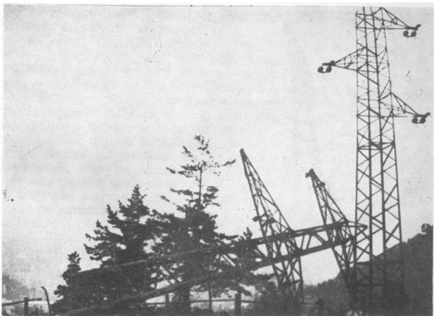
Stub električnog dalekovoda kod Plejske Dubrave koji su srušili borci Jeseničke partizanske čete 14. septembra 1941.
